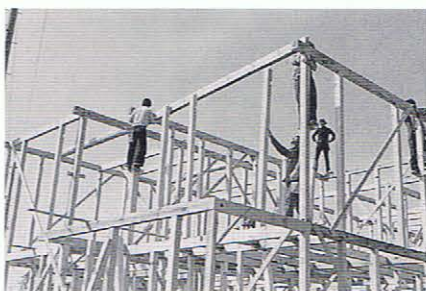
[上] 当時のパンフレットより代表的な一戸建3タイプ。 [中] 前方基礎工事中。この面積に少なくとも10軒以上の住宅が建てられた。 [下] 在来工法による2階建方の様子。
